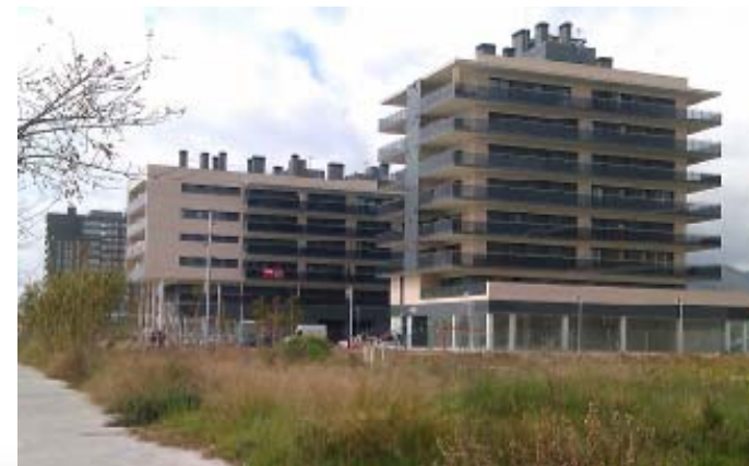
Edificis de vivendes connectades al Tub Verd en El Rengle
